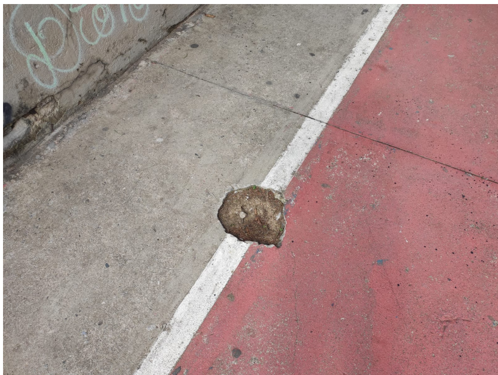
Quadra em péssimas condições
