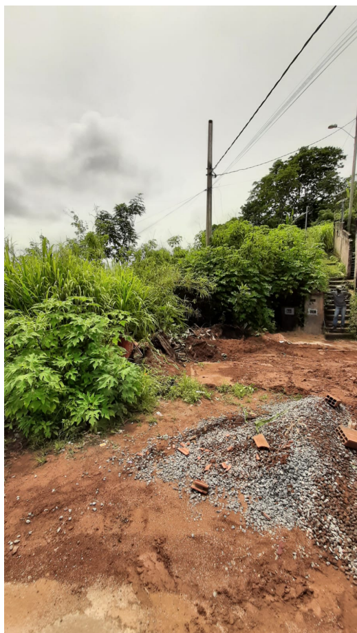
Presença de lama ao longo da via
