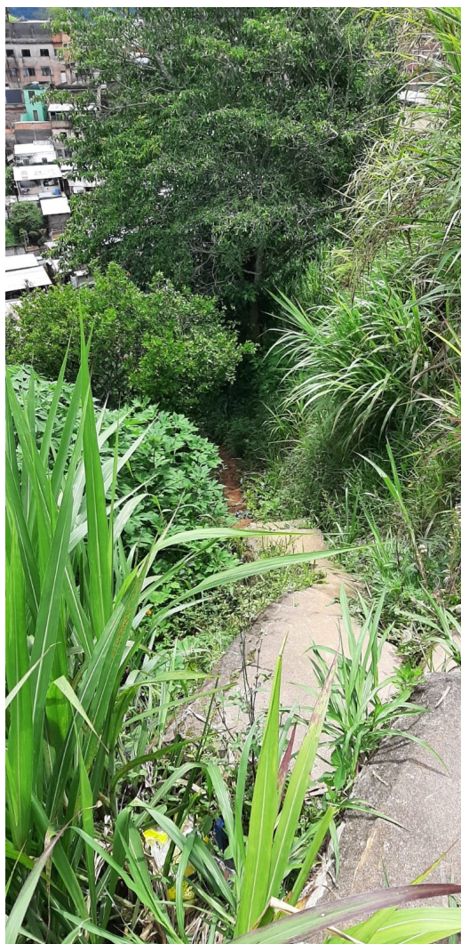
Área de escoamento de águas pluviais
