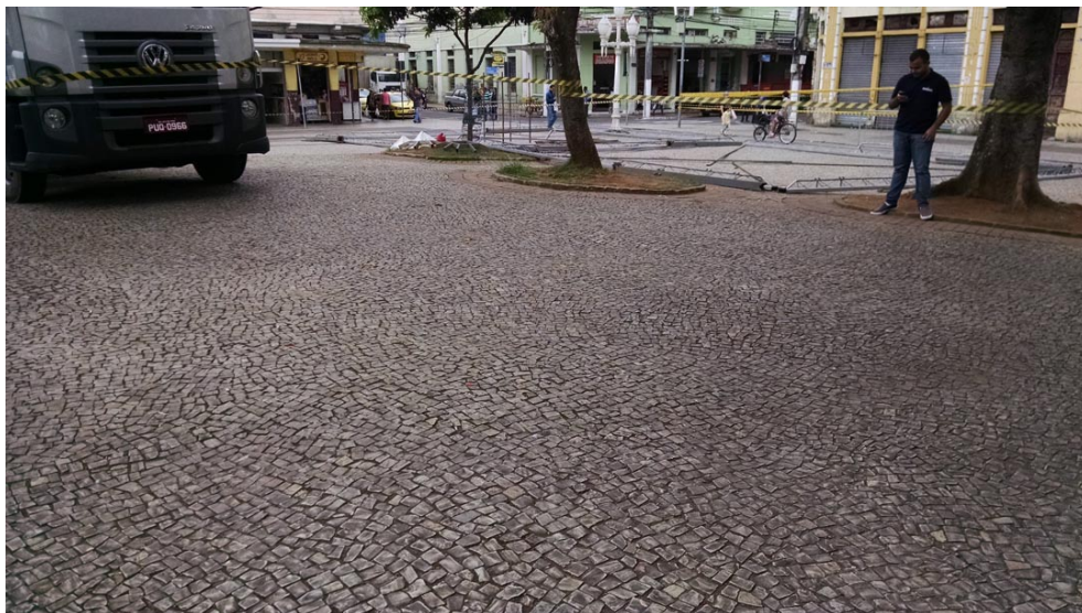
Vsita parcial da praça
