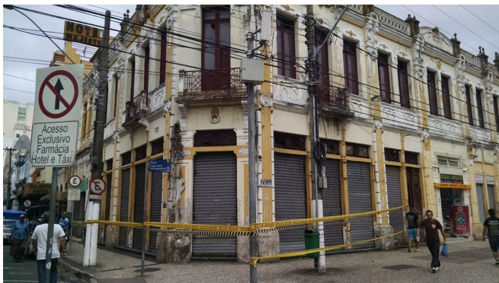
Área isolada pela Defesa Civil ao redor de prédio histórico
