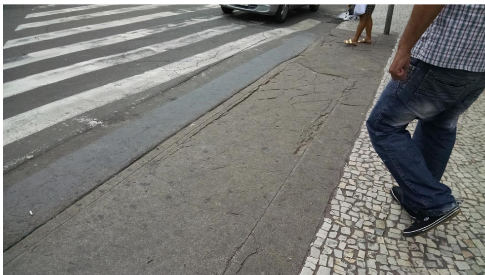
Faixa de pedestres - Apagada necessita de pintura
