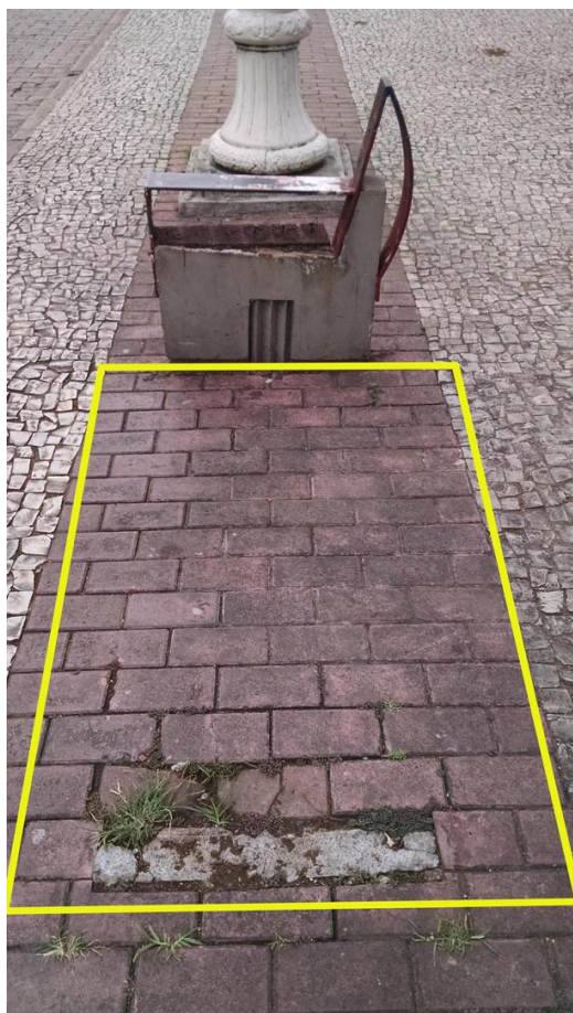
Banco destruído com partes ausentes
