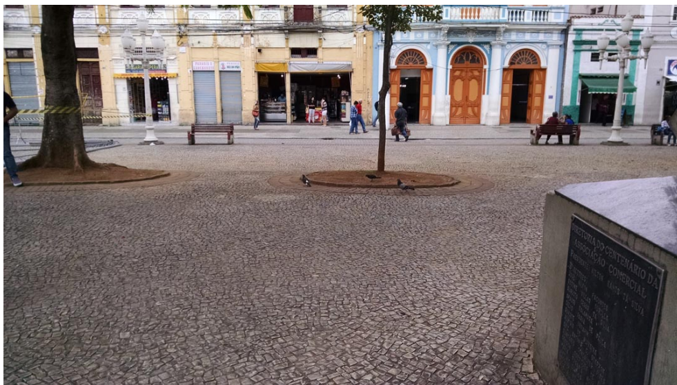
Vsita parcial da praça
