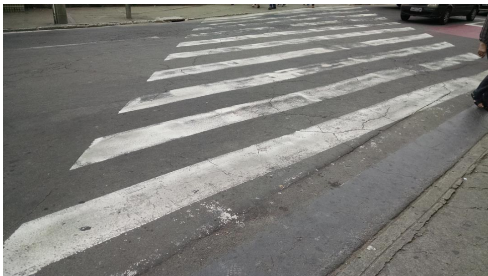
Faixa de pedestres - Apagada necessita de pintura
