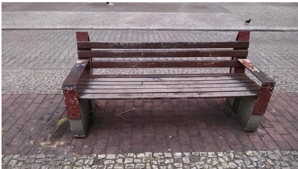
Bancos que necessitam de reformas e/ou pintura
