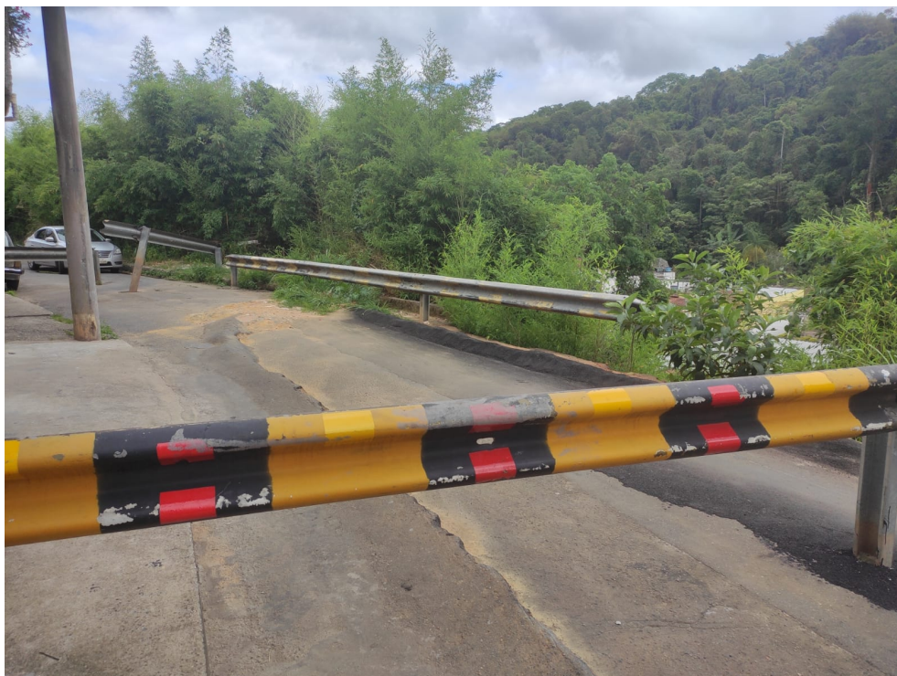
Introdução de guard rail para impedir acesso à veículos
