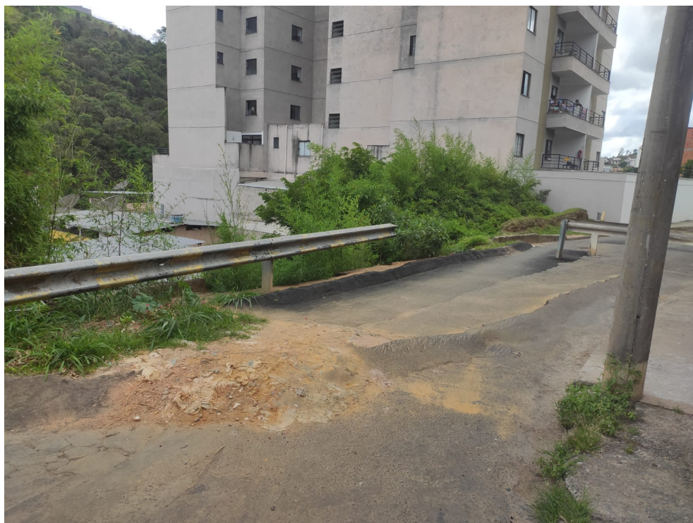
Barreiras para acesso de veículos na via
