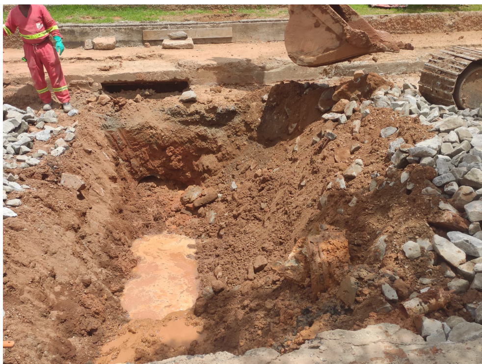
Conserto na tubulação de esgoto da Avenida Ibitiguaia
