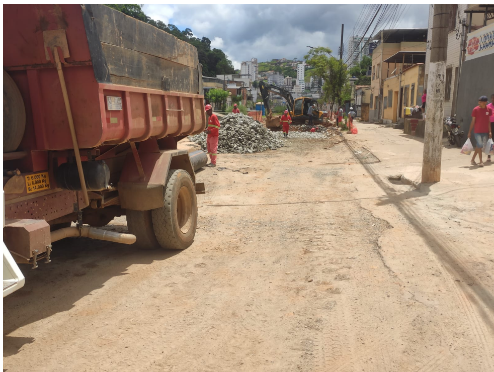
Obras na Avenida Ibitiguaia
