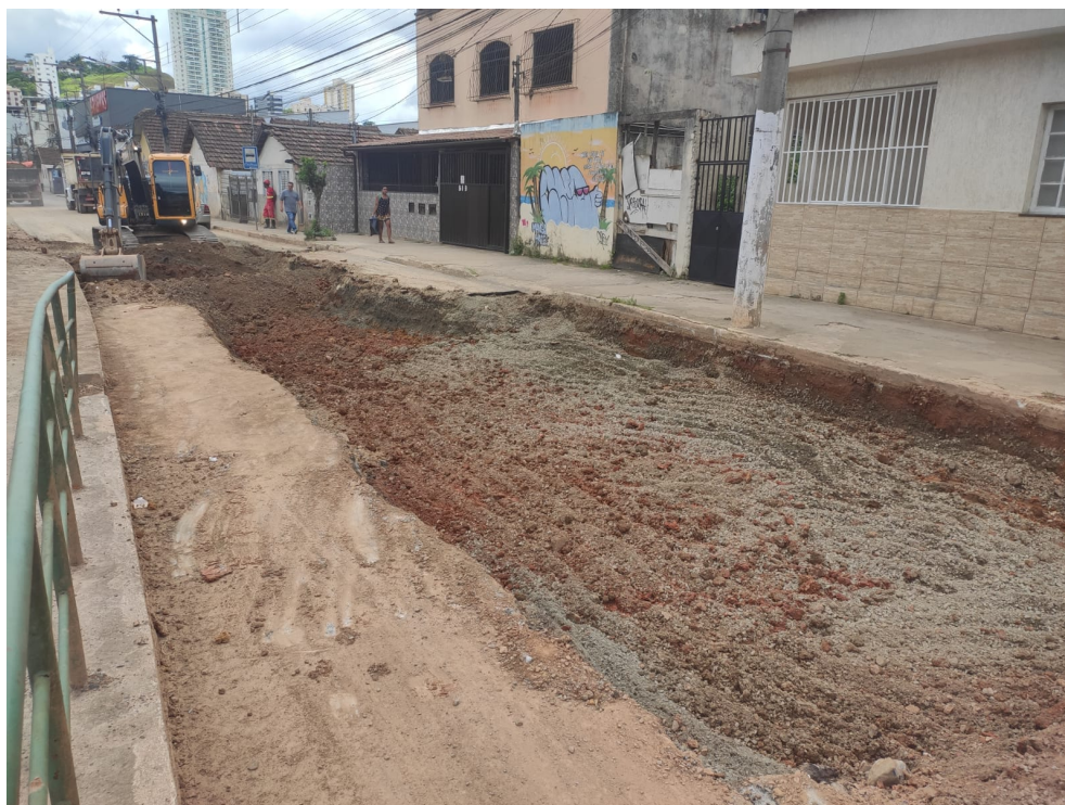
Repavimentação da Avenida Ibitiguaia
