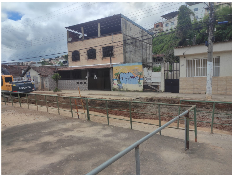
Escavação da avenida na pista sentido Centro
