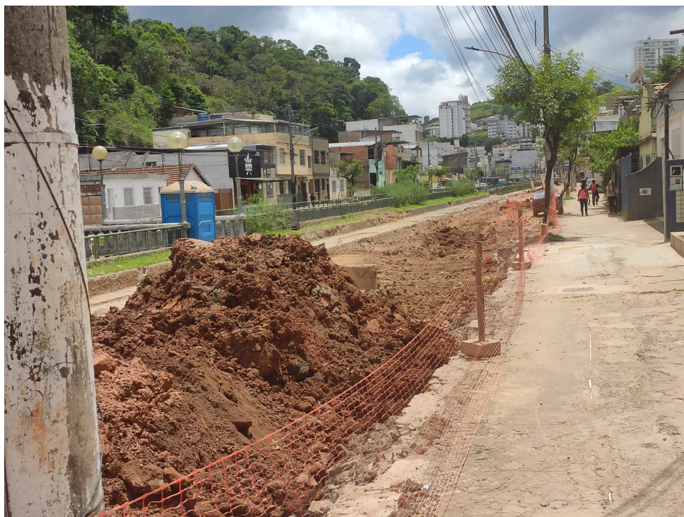
Escavação da avenida na pista sentido Centro
