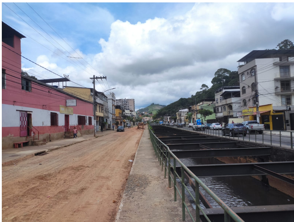
Obra na Avenida Ibitiguaia
