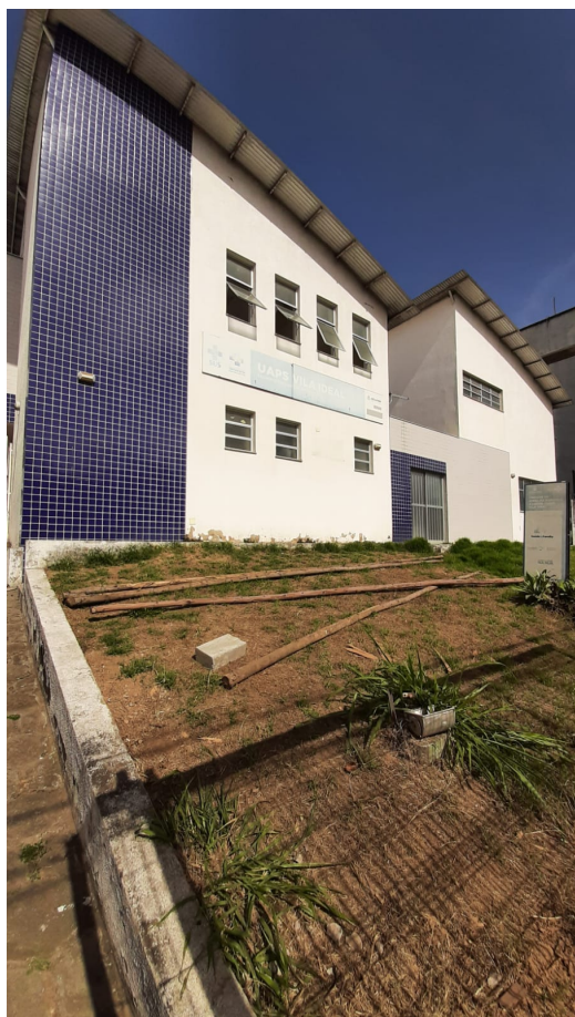
Fachada da UBS Vila Ideal
