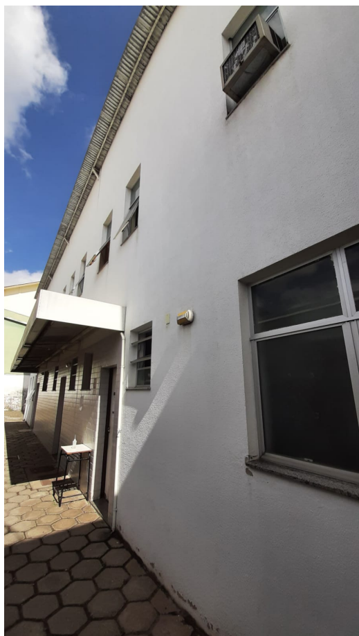
Fachada lateral da UBS Vila Ideal
