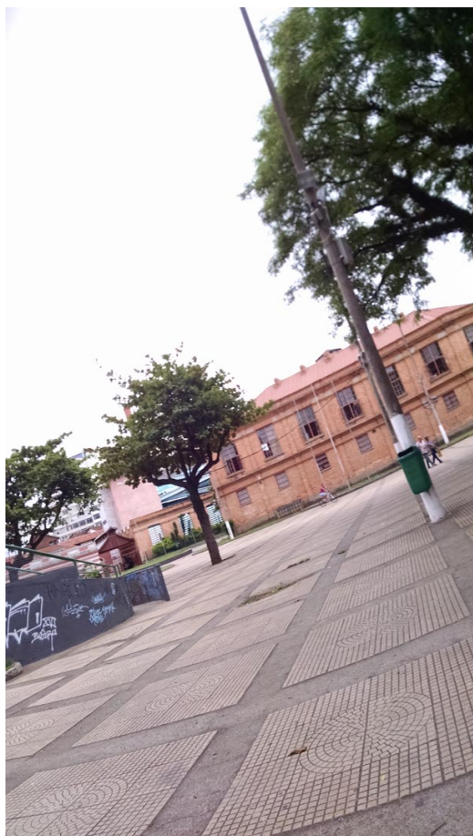
Vsita parcial da praça
