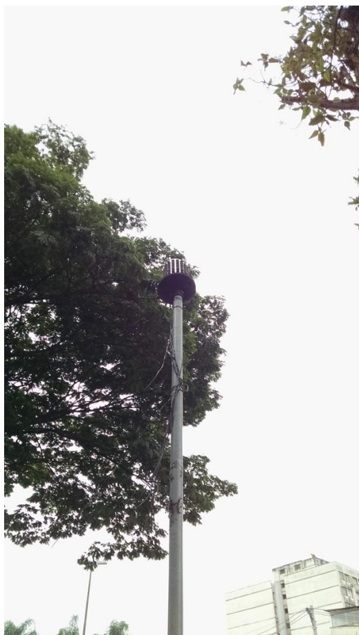
Sistema de iluminação cotidiana da praça sem os globos de proteção
