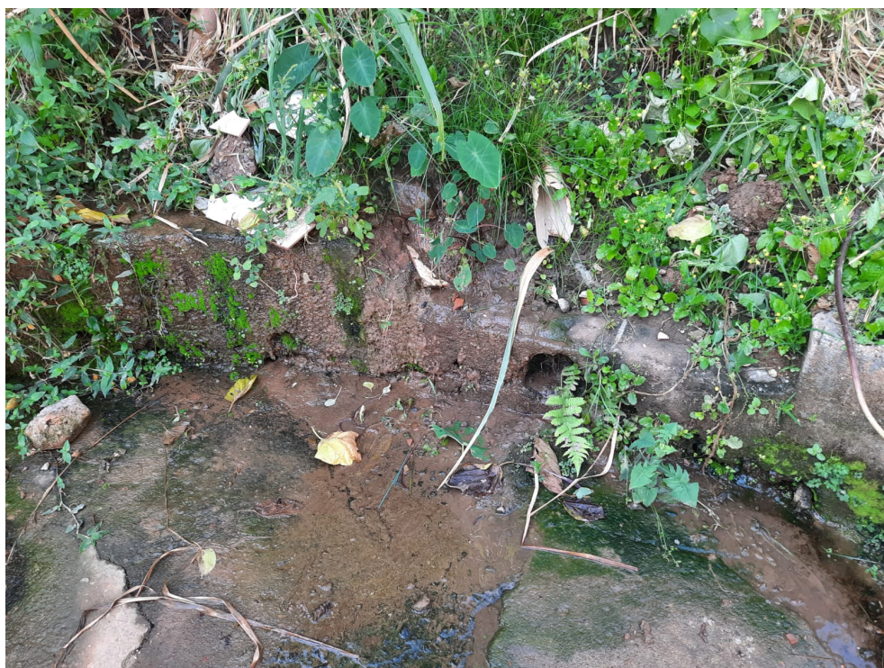
Escoamento inadequado da mina presente no fim da Rua Horanides Maria Aparecida
