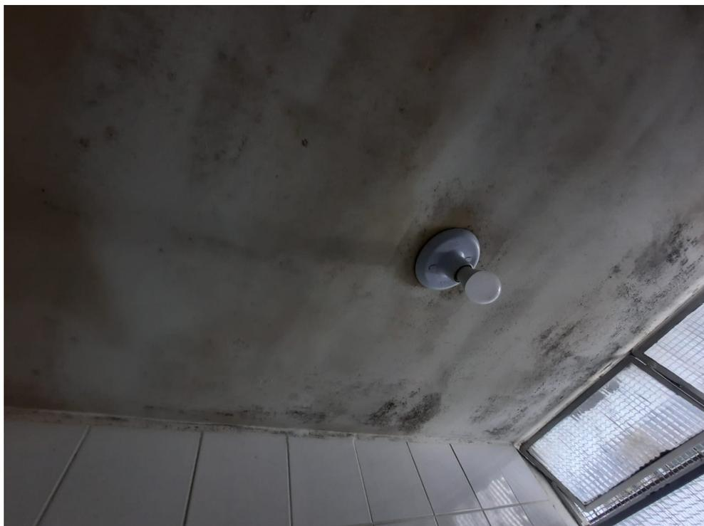
Teto com presença de infiltração e mofo aparente
