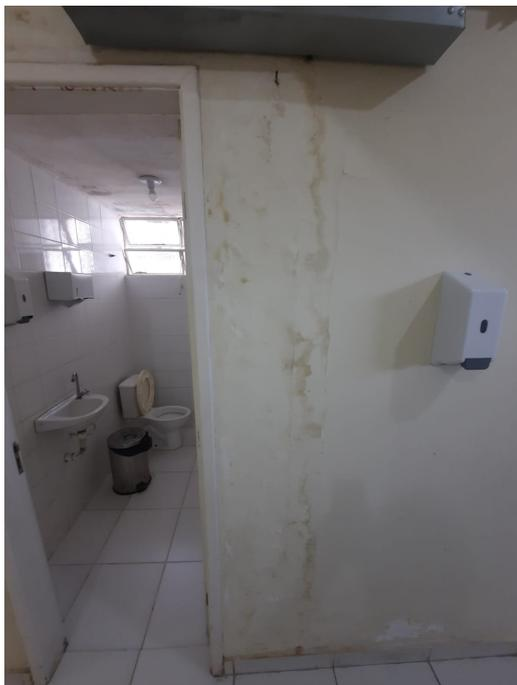
**Parede com presença de infiltração e mofo**
