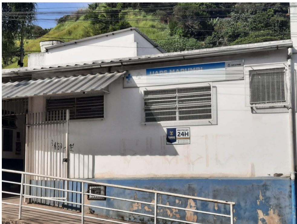
Fachada da UBS Marumbi
