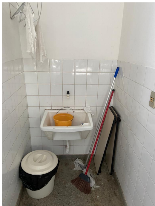
Área de limpeza
