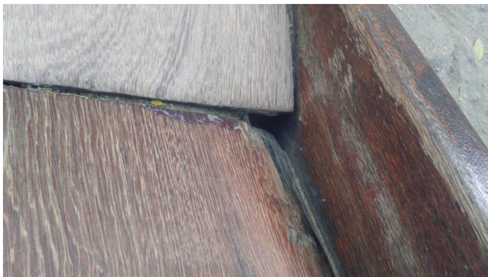
Frestas no escorregador do parquinho
