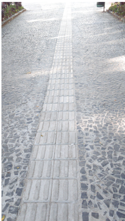
adequação do piso para portadores de necessidades especiais
