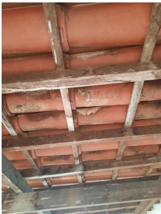
Telhado com vazamento de água
