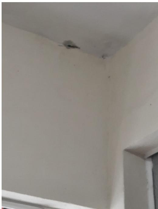
Presença de mofo e infiltração no teto da Unidade
