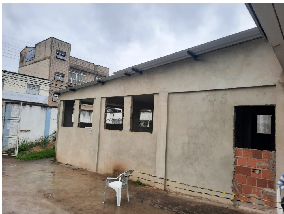
Anexo da UBS em construção
