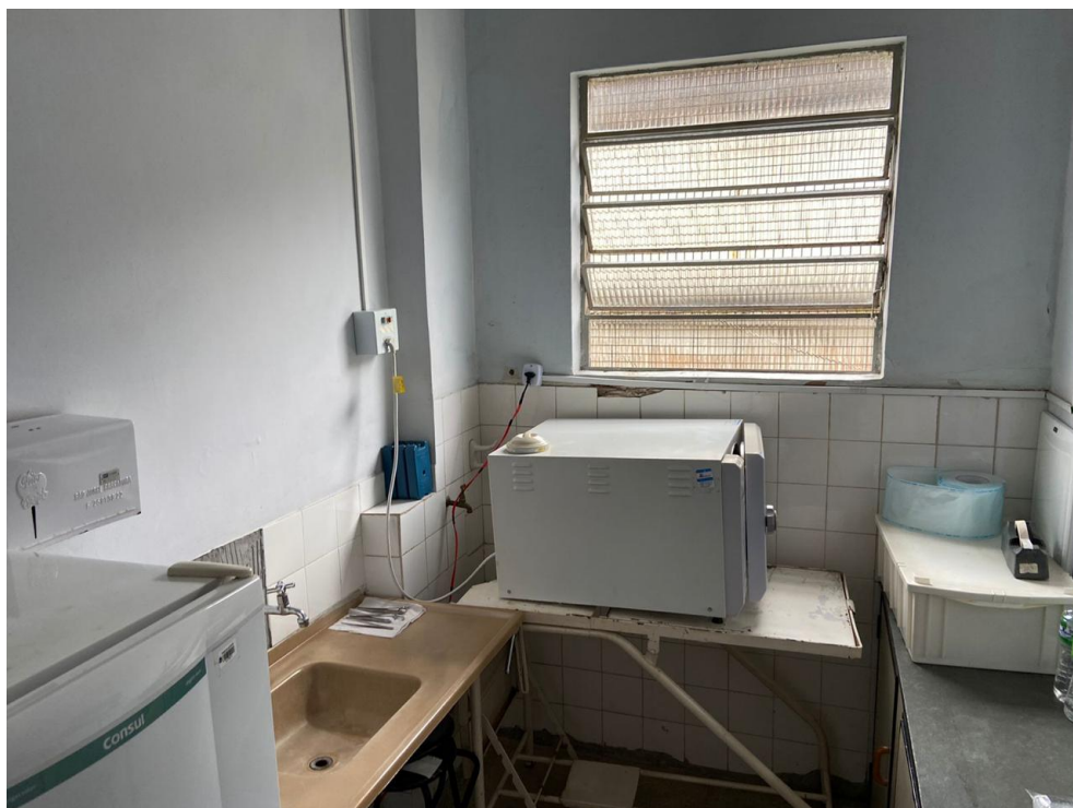
Sala de esterilização
