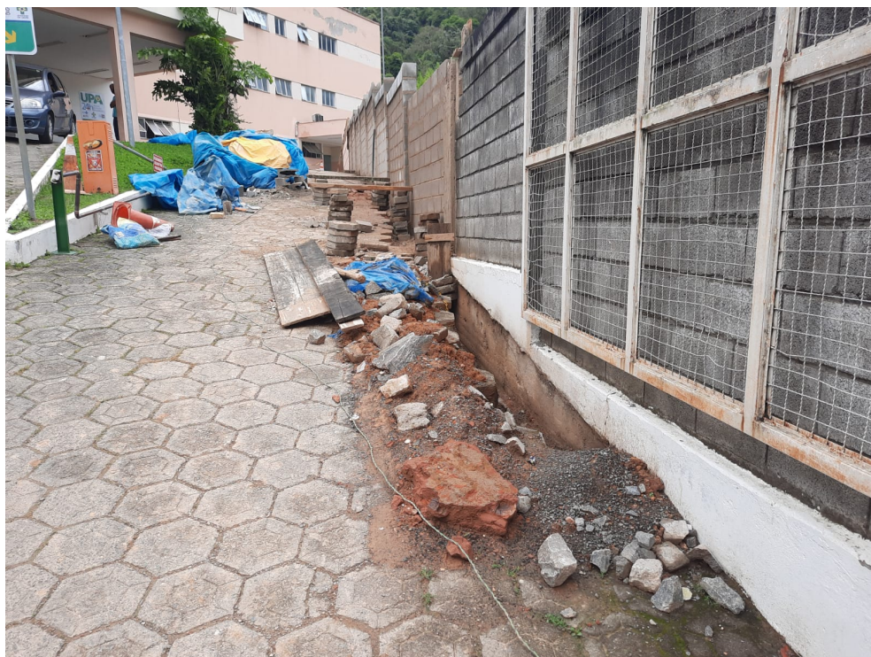
Reforma no acesso ao estacionamento da UPA Santa Luzia
