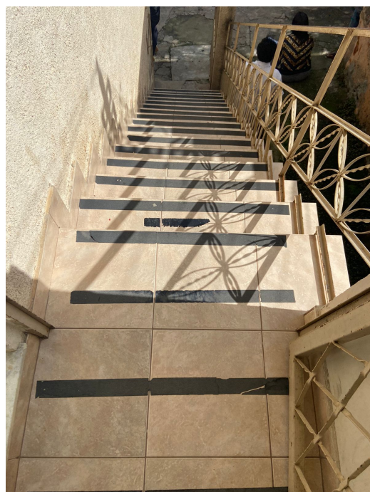
Escada de acesso ao andar superior da Unidade
