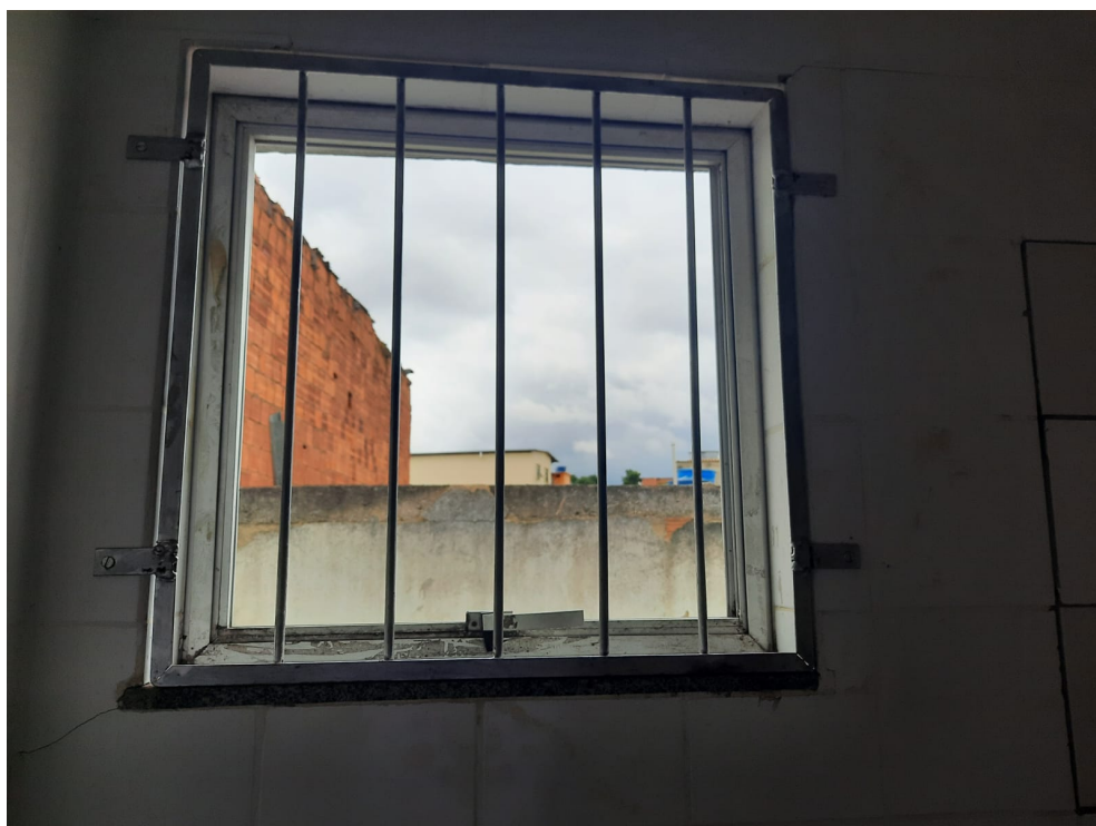
Janela sem vidro
