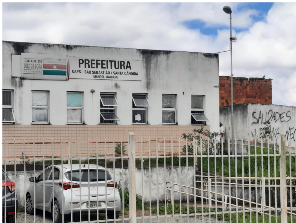
Fachada da UBS São Sebastião
