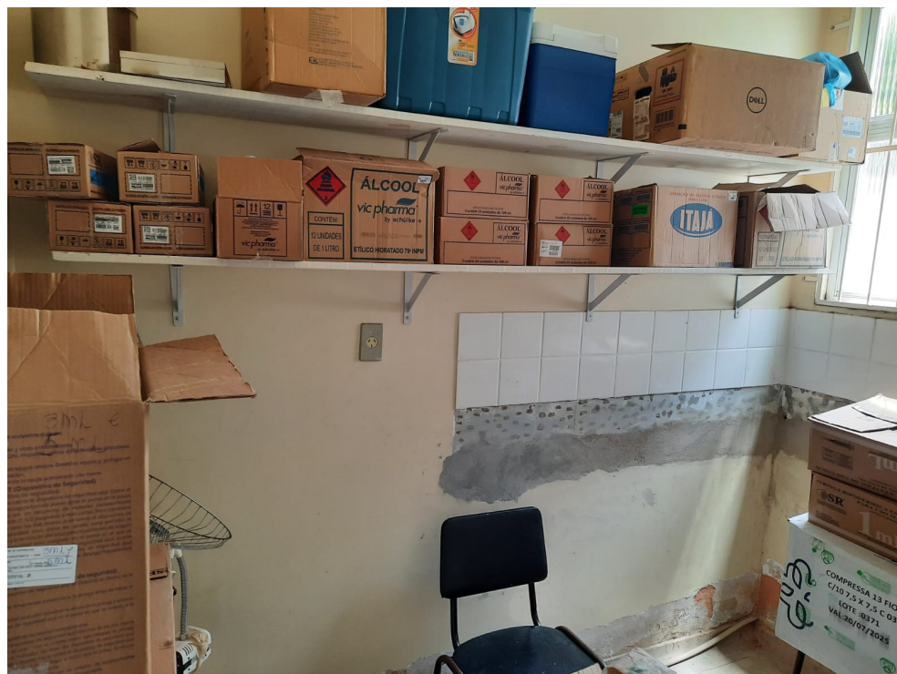
Local de armazenamento de insumos
