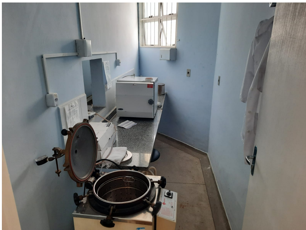
Sala de equipamentos
