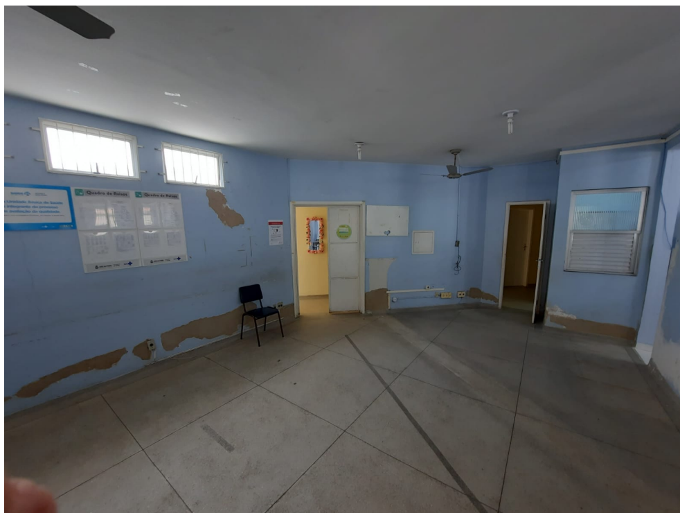
Área interna da UBS
