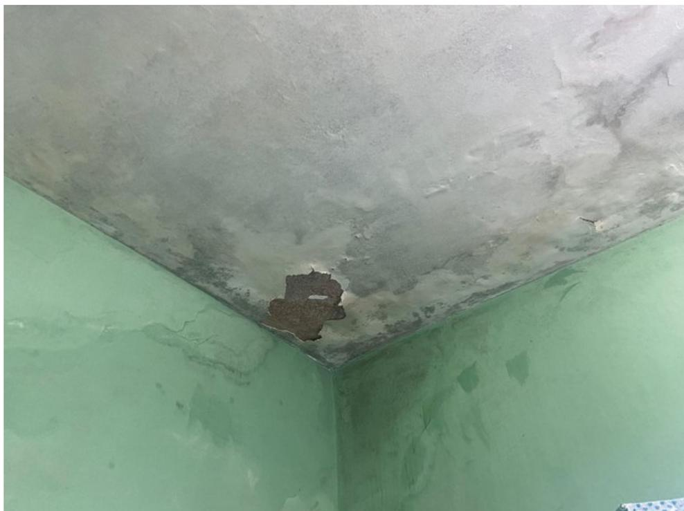
Detalhe da parede com mofo e infiltração
