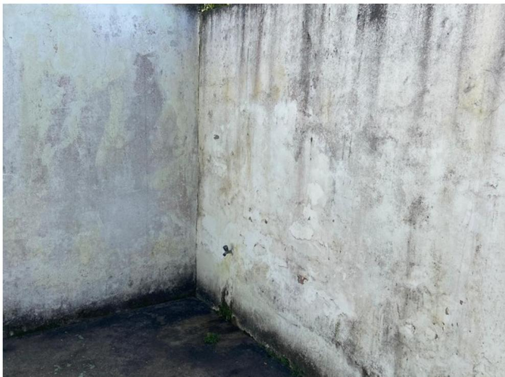
Muro externo com alta incidência de mofo
