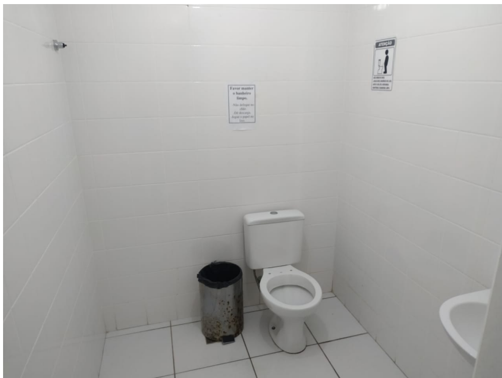
Banheiro destinado aos pacientes sem barras de apoio nas paredes
