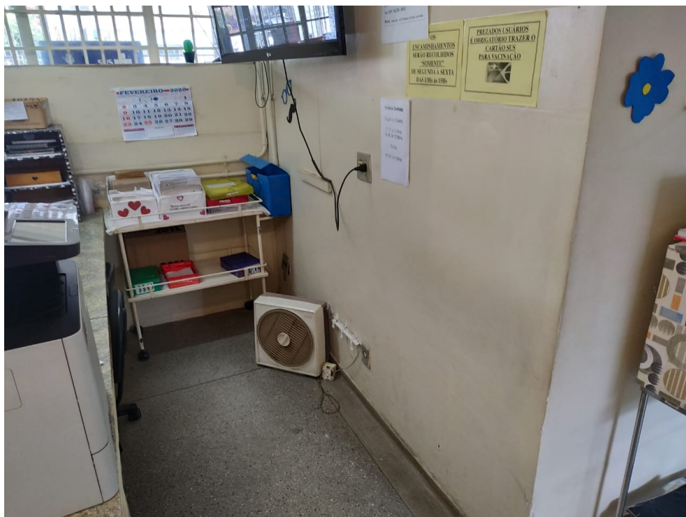
Ventilador particular usado para amenizar o calor na UBS
