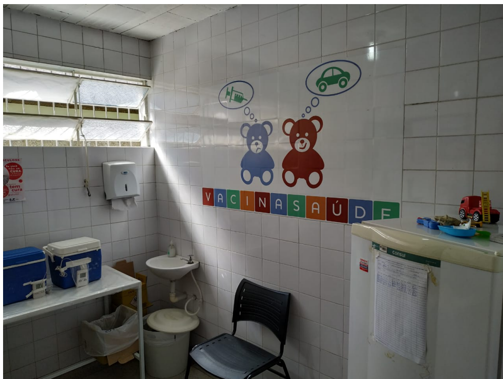
Sala de vacinas sem ar condicionado e câmara adequada
