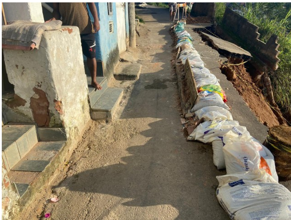
Rua José Orozimbo de Oliveira com passagem parcial (apenas para pedestres)
