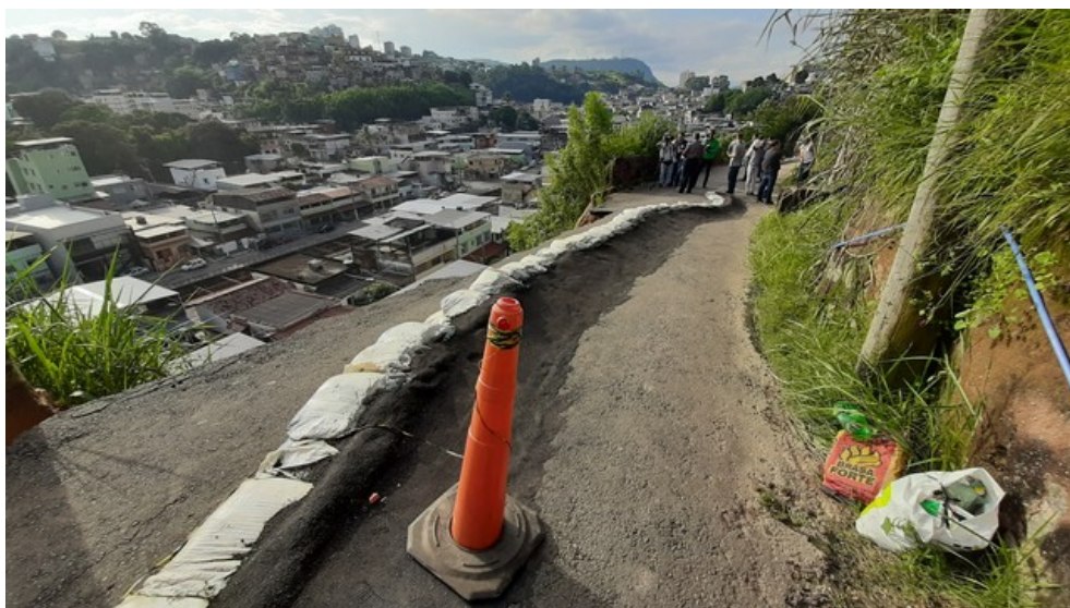
Sinalização de alerta provisório instalado nas proximidades
