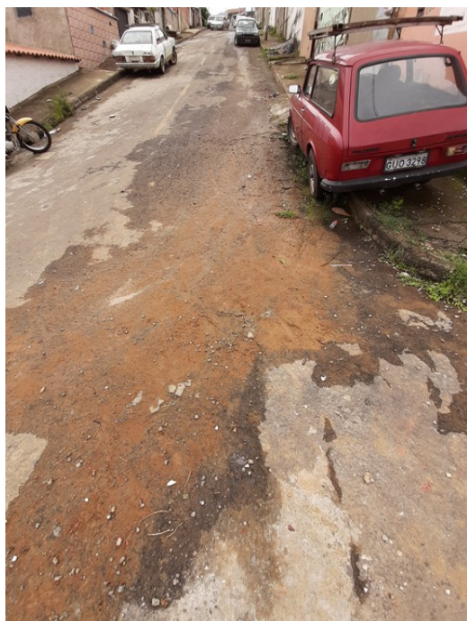
Asfalto da rua Onofre de Paiva em más condições
