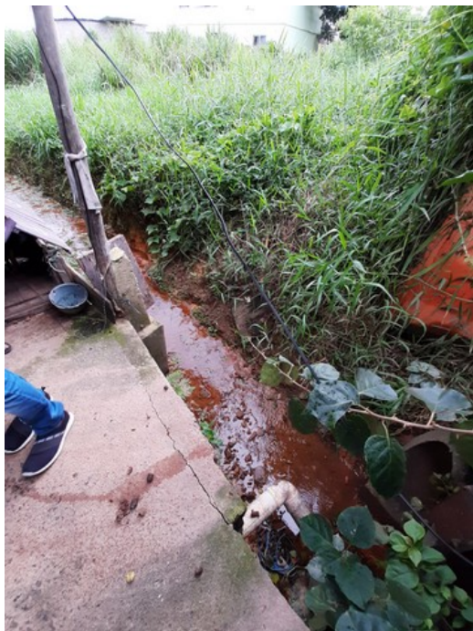
Curso d'água que deságua no córrego Três pontes
