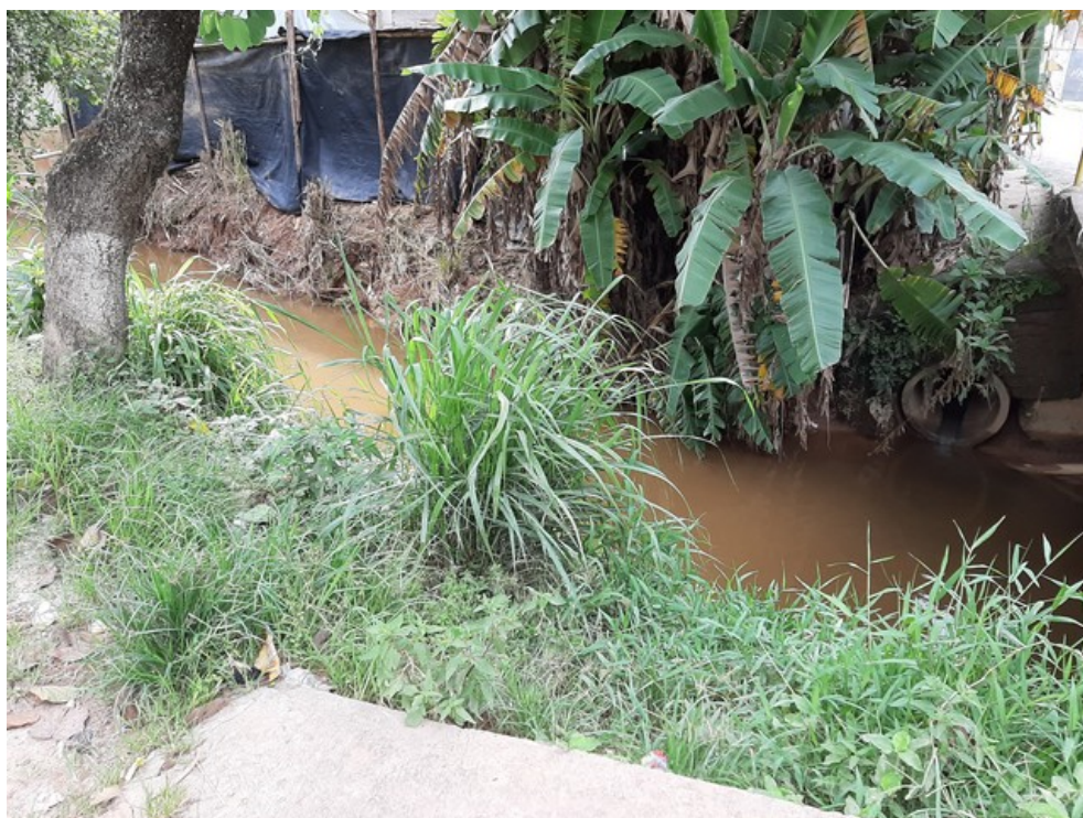
Falta de Capina no leito do Córrego Três Pontes
