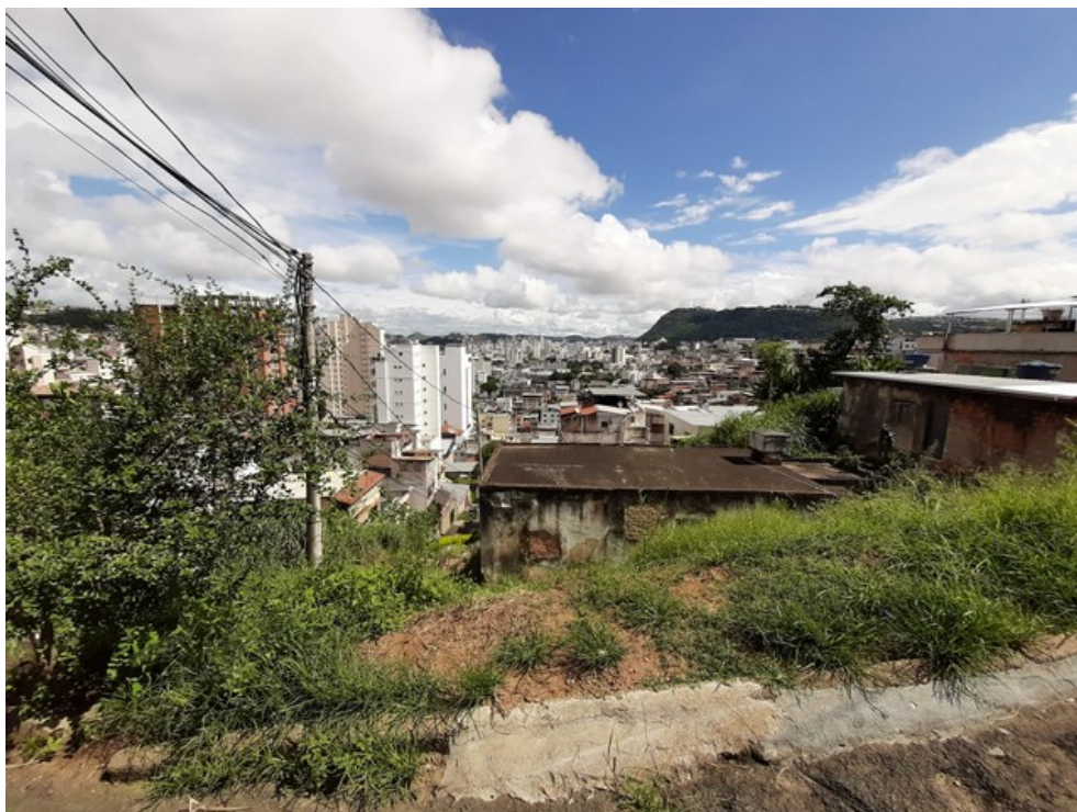
Trecho da rua V. Saggiaro (parte de cima do escadão) sem iluminação noturna adequada
