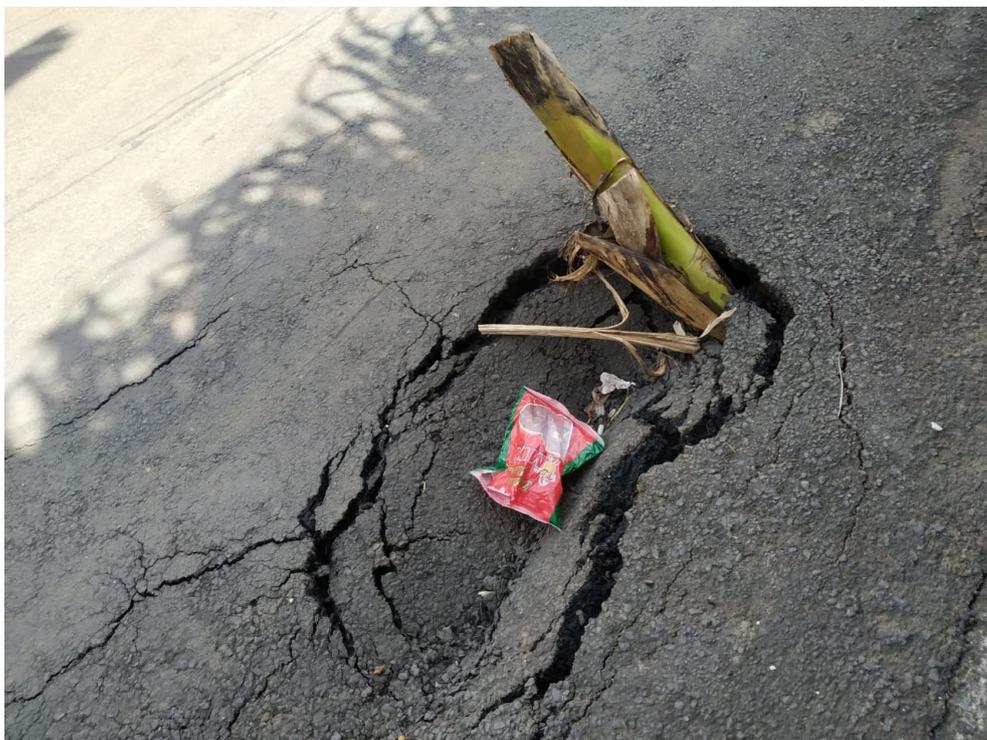
**Asfalto danificado devido às infiltrações da rede de esgoto**
