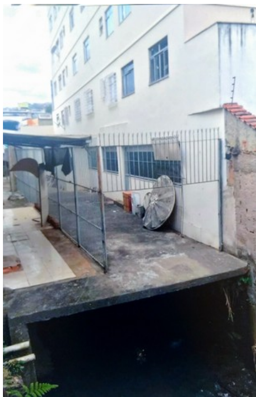
Laje com gradil construída entre a parte de trás do Edifício Havana (Rua Eugênio Fonta
