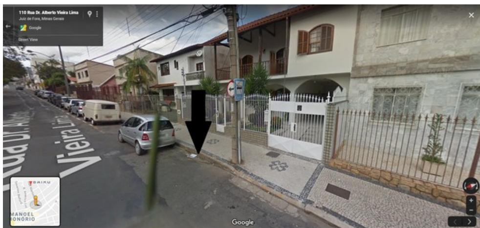
Tampa de bueiro concretado na Rua Alberto Vieira Lima 134 (Esquina com Rua Irmão Marti)
