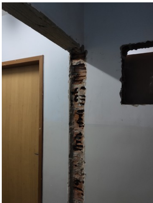
Obra em andamento
