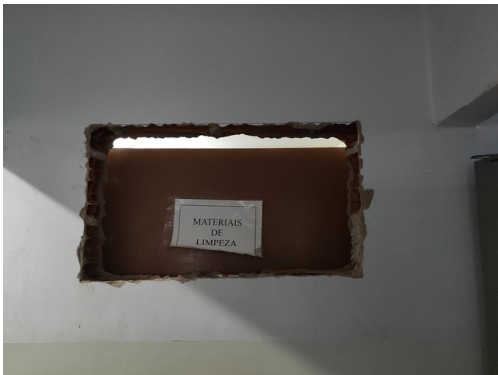
Obra em andamento
