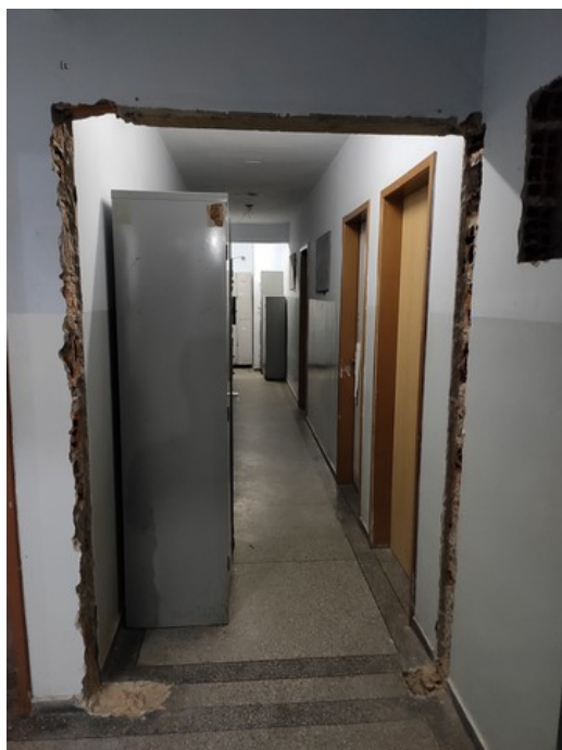
Obra em andamento
