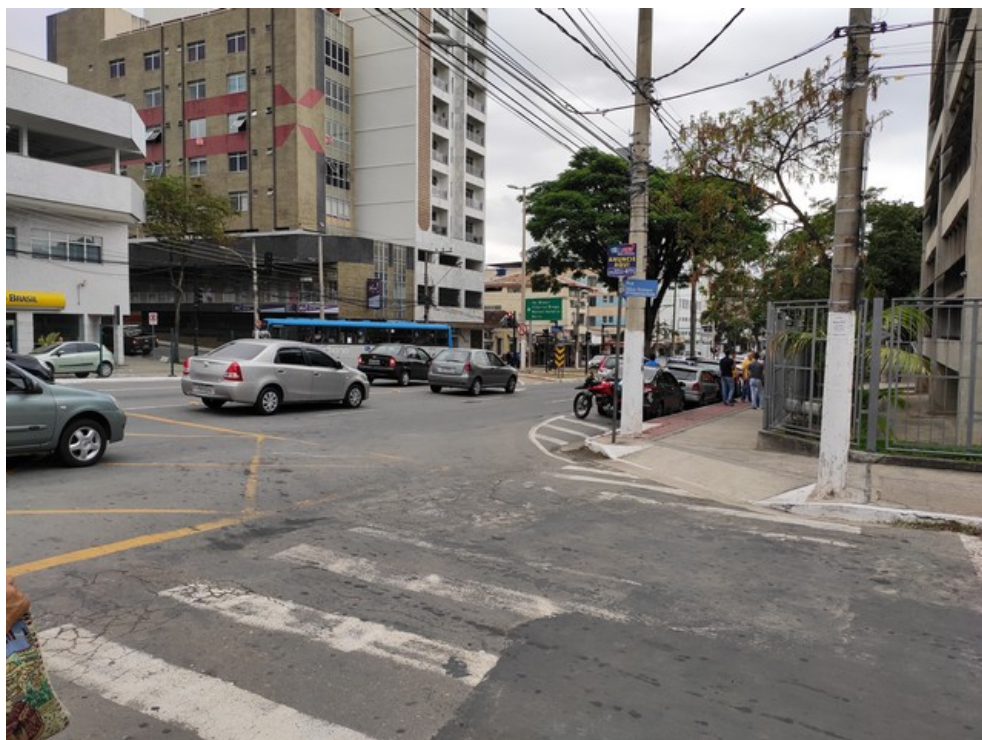
Faixa de pedestres necessitando de reforço na pintura na Rua Silvio Romero
