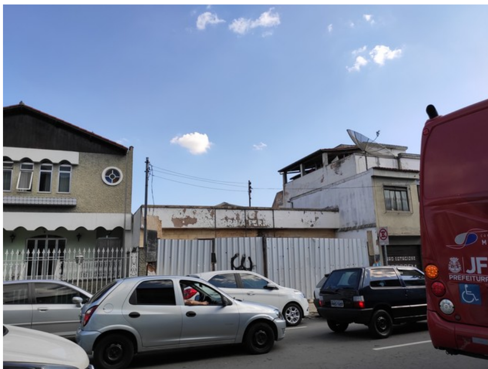
Terreno destinado à construção de UBS
