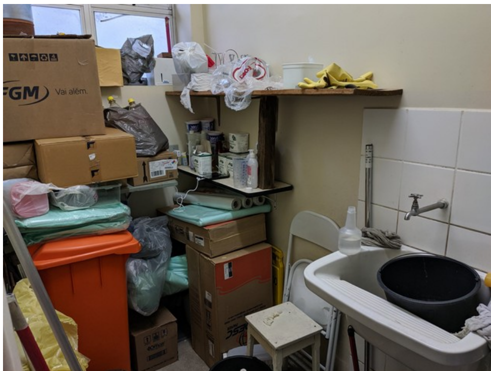
Sala de Material de Limpeza e Expurgo Improvisada
