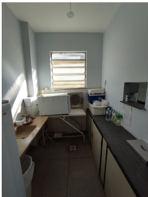
Autoclave armazenado improvisadamente na Sala de Esterilização
