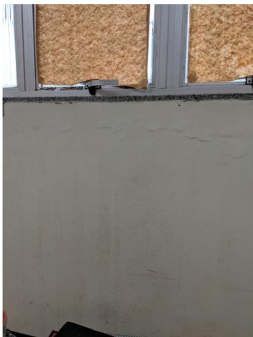
**Infiltração na parede e janela danificada na farmácia**
