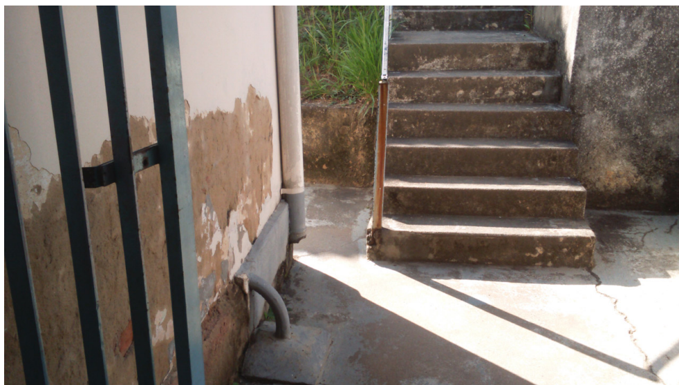
Corredor e escada de acesso à unidade odontológica
