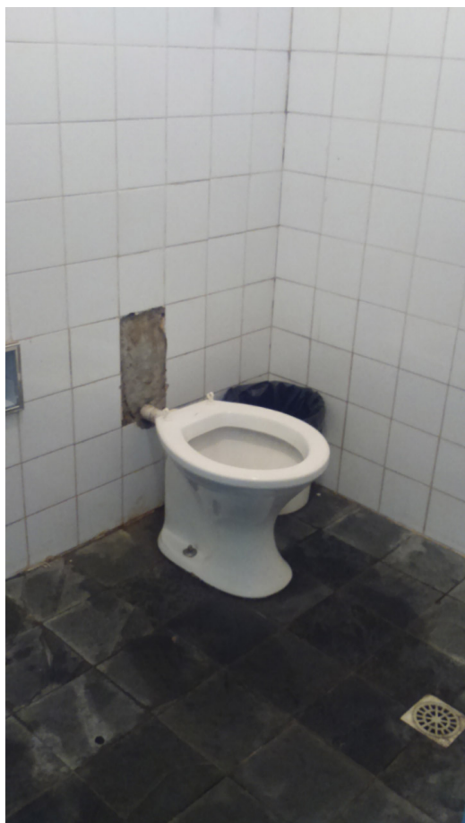
Banheiro de usuários
