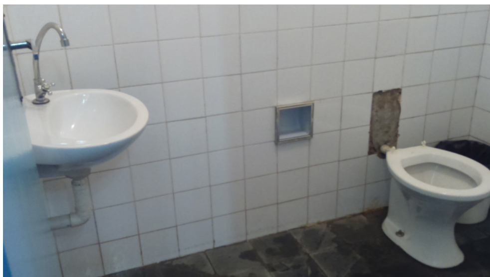
Banheiro de usuários
