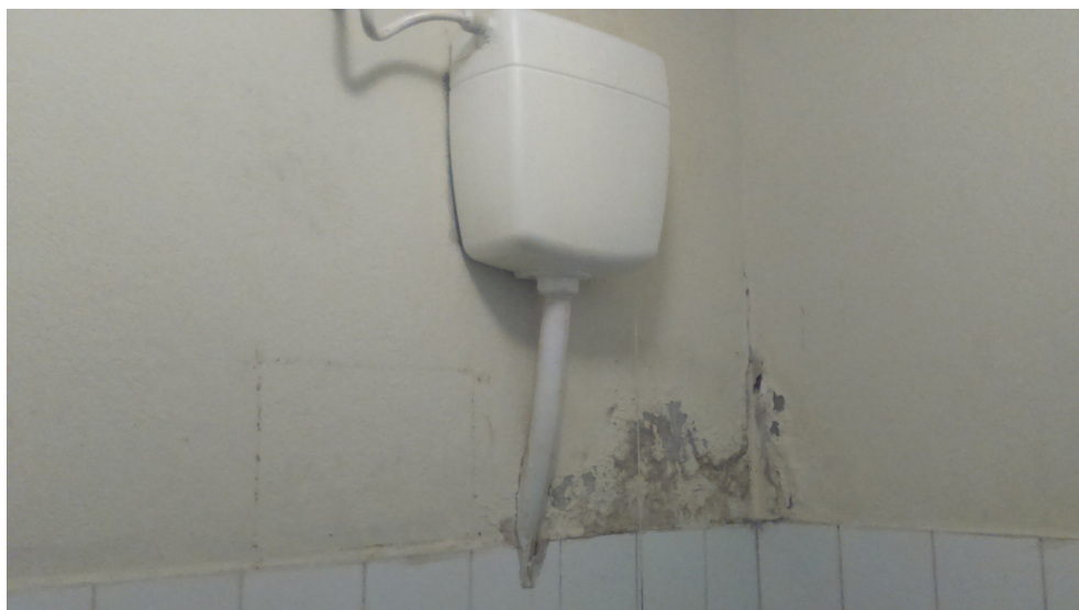
Banheiro de usuários
