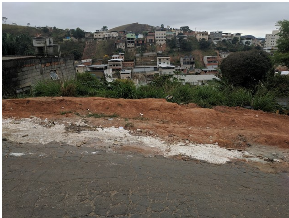
Buraco visto de frente e terreno íngreme ao fundo
