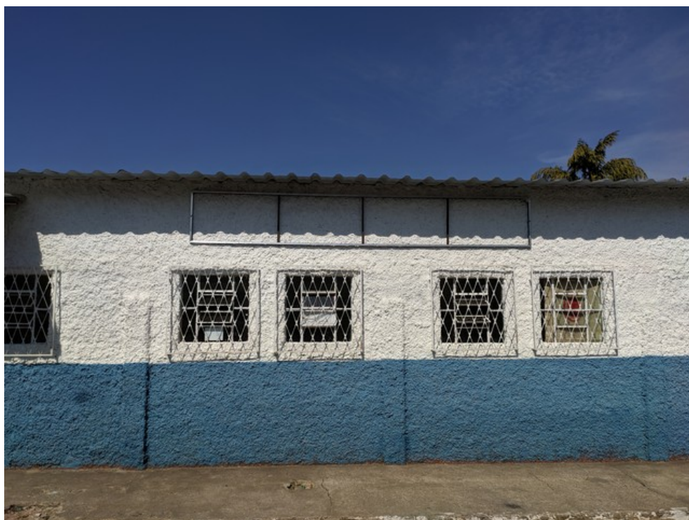
Fachada sem o nome da unidade
