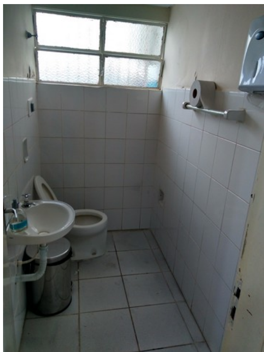
Banheiro não adaptado, em fevereiro
