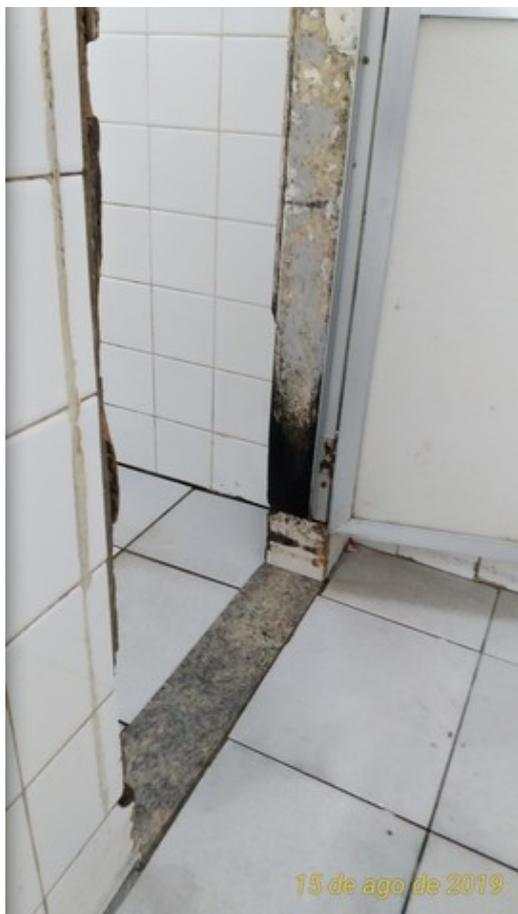
**Mofo e ausência de azulejos na parede**
