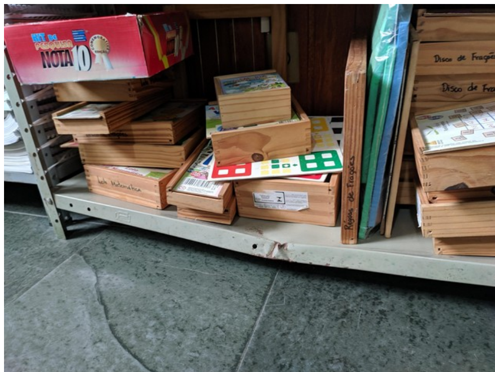
Prateleira empennada na Sala de Coordenação
