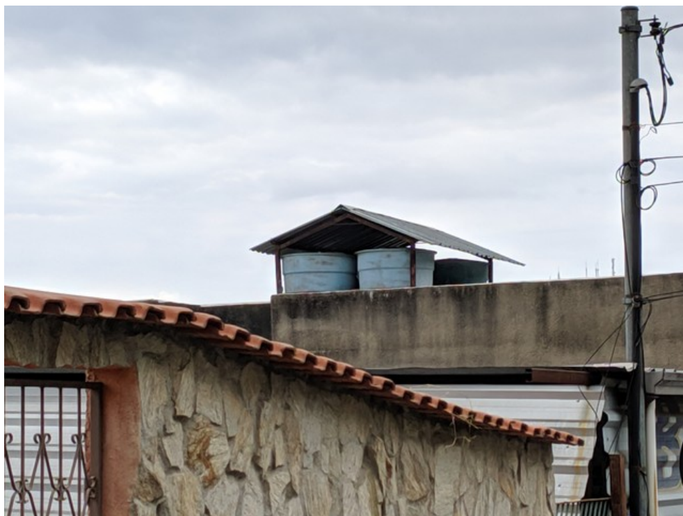
Caixas d'água em imóvel abandonado
