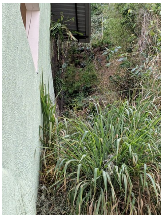
Caminho por onde animais peçonhentos descem para a via, na lateral do terreno baldio
