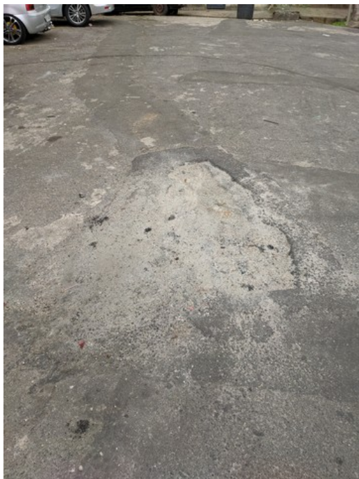
Correção de buraco no asfalto
