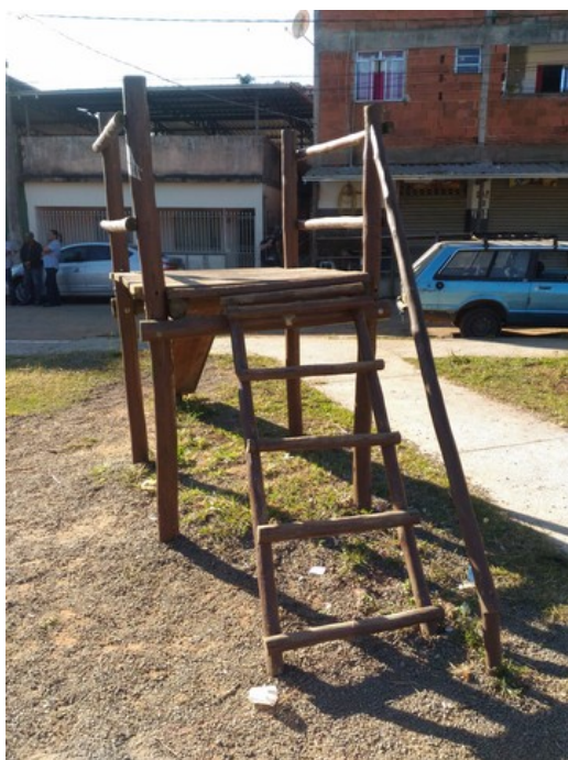
Escorregador sem corrimão
