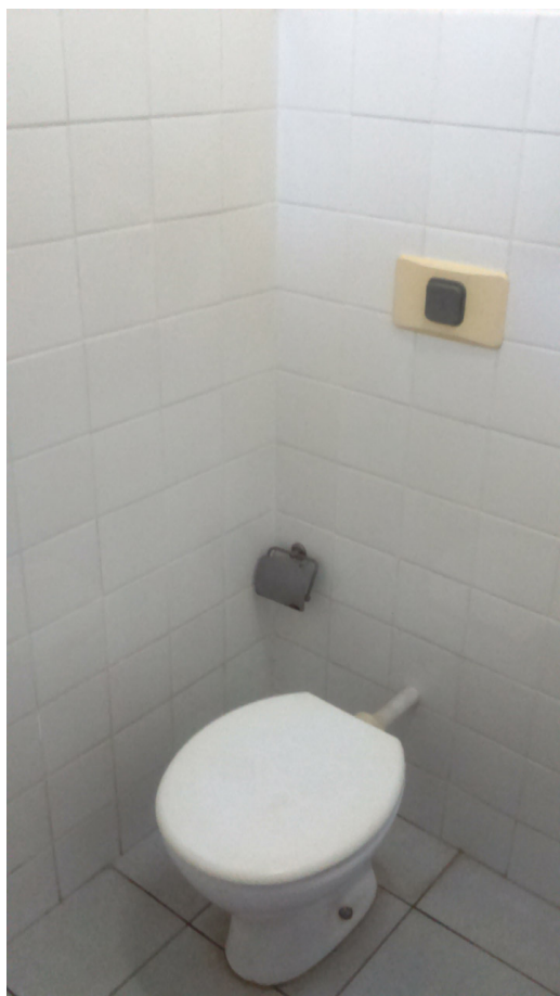
Banheiro de usuários
