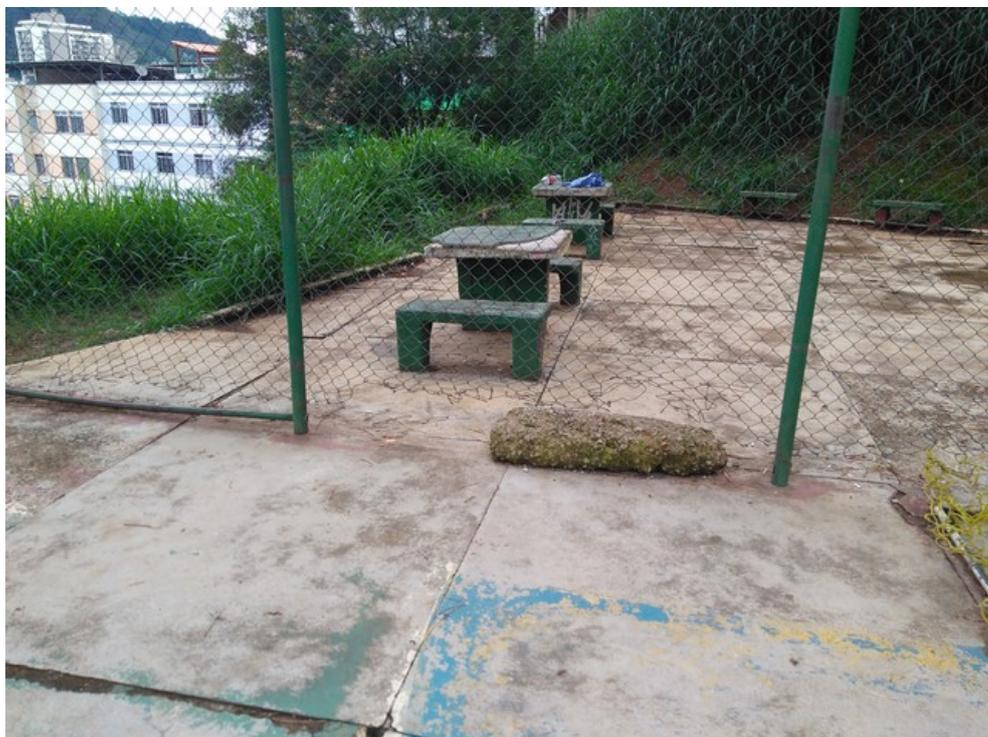
Bloco de concreto solto na praça junto a uma ruptura do alambrado
