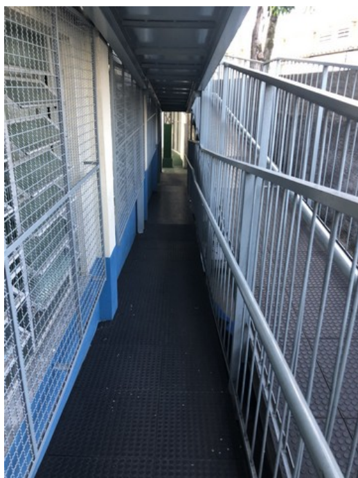
Rampa de acesso para o segundo andar
