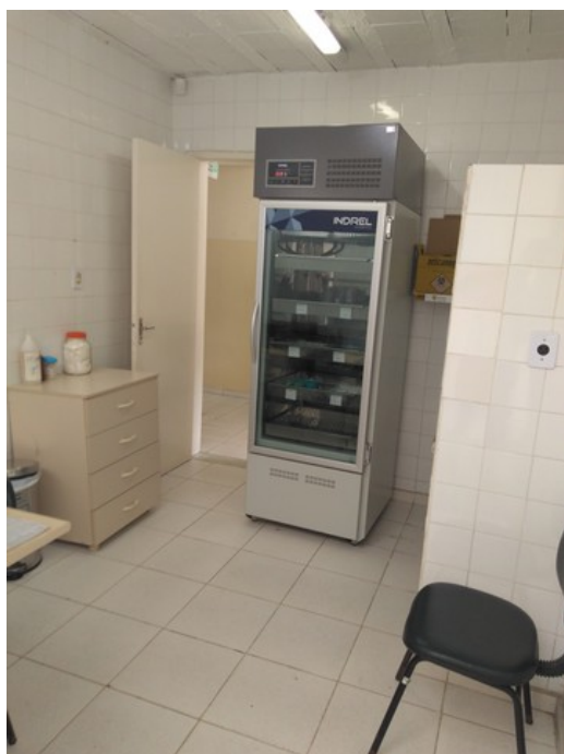
Sala de Vacinas
