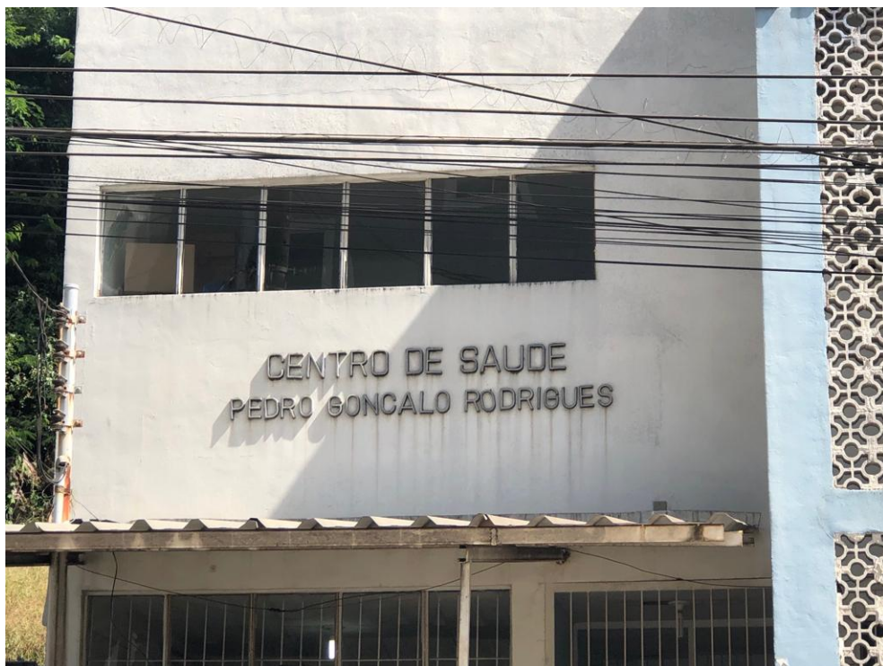
Fachada da Unidade
