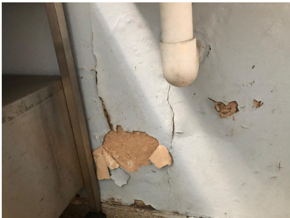
Parede da sala de coleta de materiais biológicos
