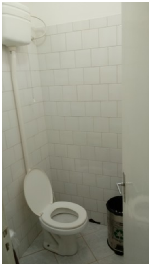
Banheiro do consultório ginecológico
