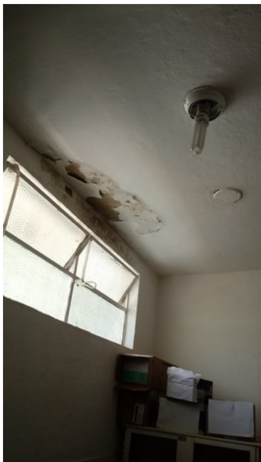
Teto da farmácia e área de compressor
