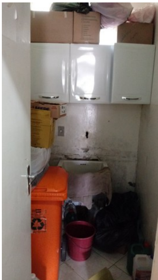
Sala de expurgo, DML e resíduos sólidos.
