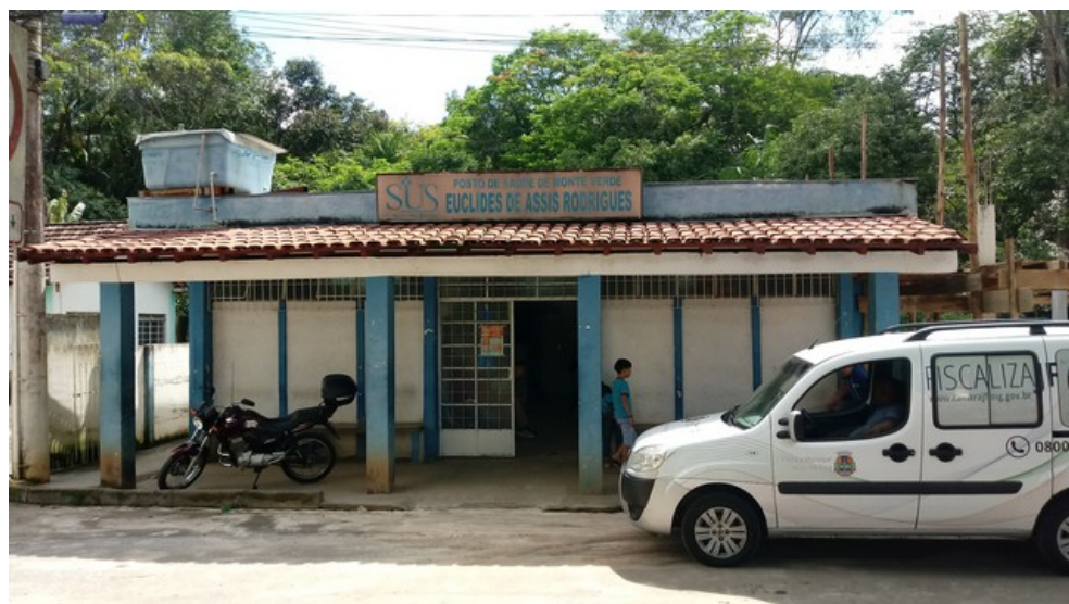
Fachada da Unidade
