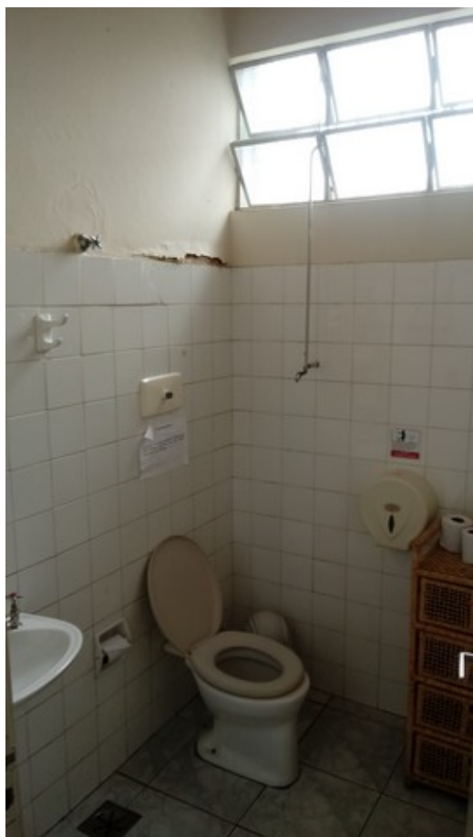
Banheiro dos servidores da escola
