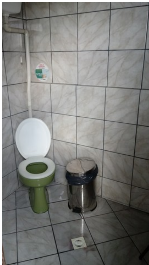
Banheiro servidores na cobertura
