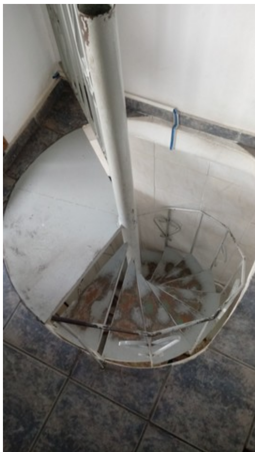
Escada de acesso à cobertura
