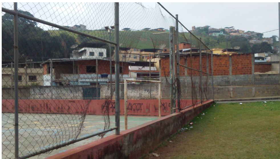
Alambrado da quadra de esportes
