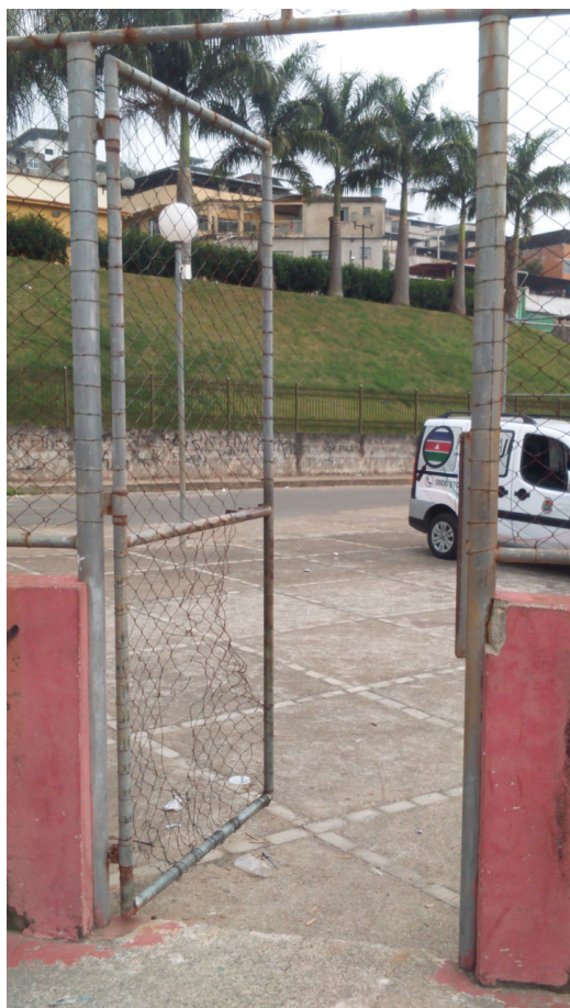
Portão de acesso à quadra
