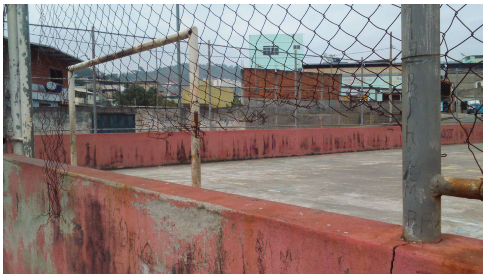
Alambrado da quadra de esportes
