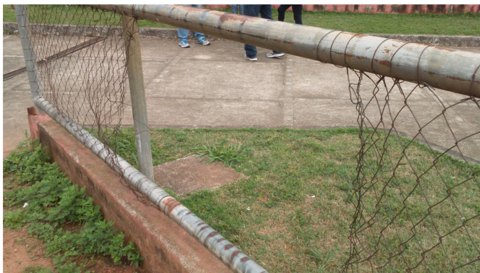
Grade de proteção do parquinho
