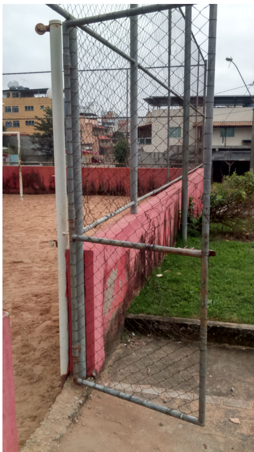
Portão de acesso à quadra de areia
