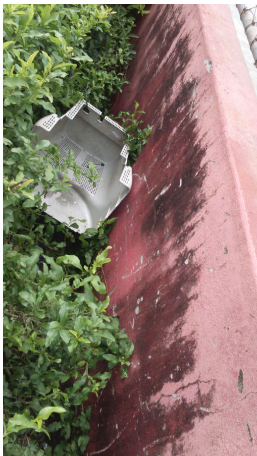
Vista da limpeza da praça
